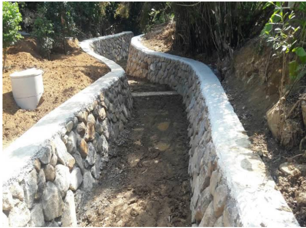
圖 3 石門區九芎林 14 鄰附近野溪整治工程
