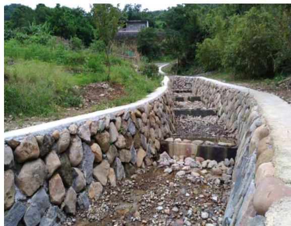
圖 4 石門區九芎林支流下游護岸整治工程
