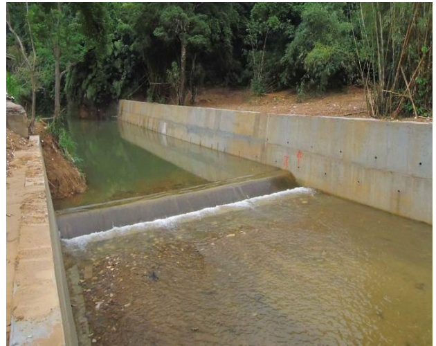
圖 2 汐止區八連路一段 292 巷旁八連溪整治工程
