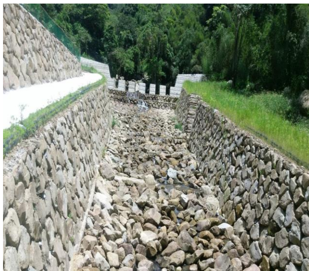
圖 1 三峽區有木里紅龜面野溪 0617 大雨災害搶修復建工程
