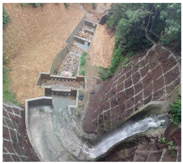
圖 6 泰山區大科里大科路 752 號附近坑溝復建工程
