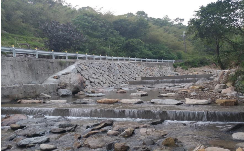
圖 5 雙溪區牡丹里牡丹橋上游護岸整治工程
