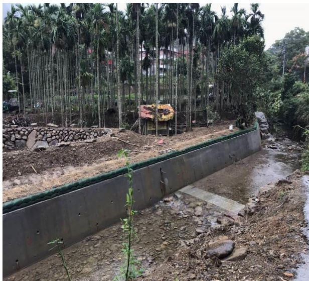
圖 5 三峽區竹崙里紫和路旁護岸整治工程
