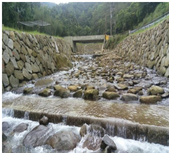
圖 2 三峽區竹崙里竹坑溪 0617 大雨災害復建工程
