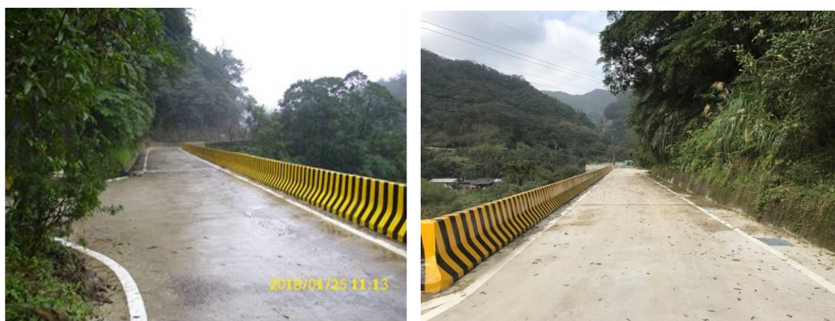
圖 3 平溪石灼坑道路完成復健
