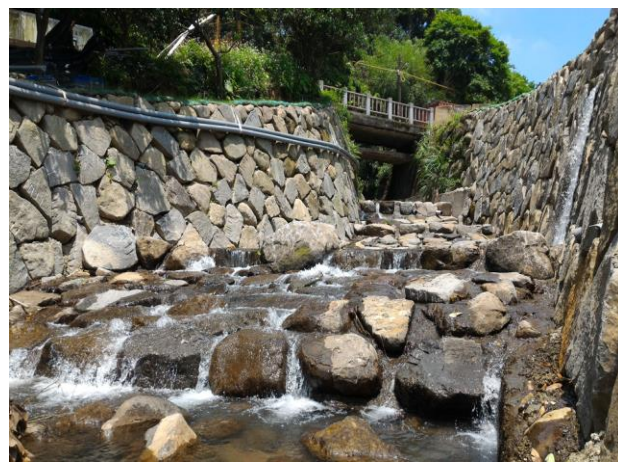
圖 10 金山區兩湖里兩湖分校旁野溪 0602 豪雨邊坡 災害復建工程-完工情形
