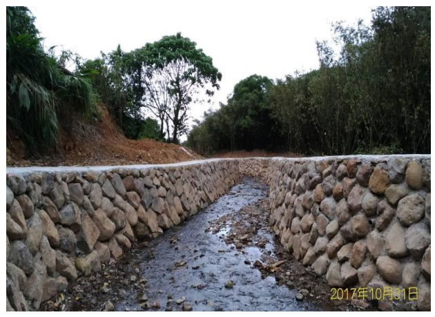
圖 4 石門區小坑仔溪護岸整治工程
