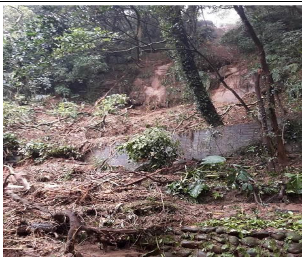
圖 7 金山區磺港里磺港路 25-2 號後方邊坡市有土地 0602 豪雨災害復建工程-災害情形
