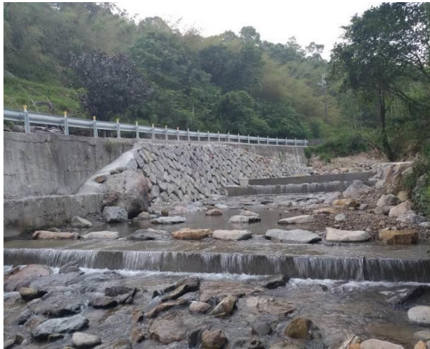
圖 1 雙溪區牡丹里牡丹橋上游野溪護岸整治工程
