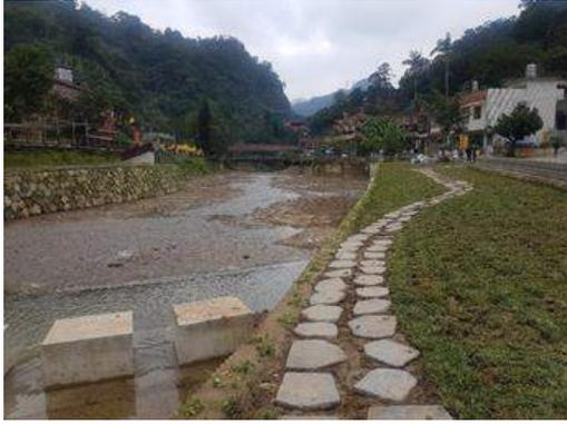
圖三 施工後砌石護岸
