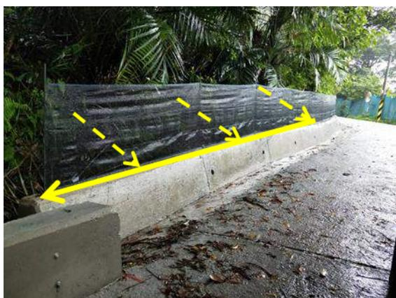
圖三 L型側溝加裝誘導網，引導生物至安全通道
