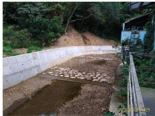
圖十 五股區民義路二段 42 之 12 號及 52 巷附近五股坑溪瑪莉亞風災復建工程-完工情形
