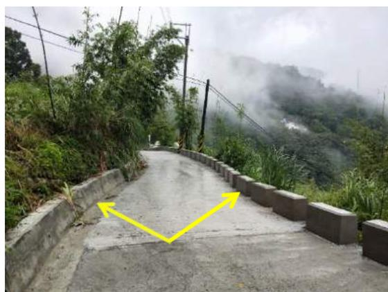
圖二 圍籬拆除使生物穿越並施作護欄防止人車掉落
