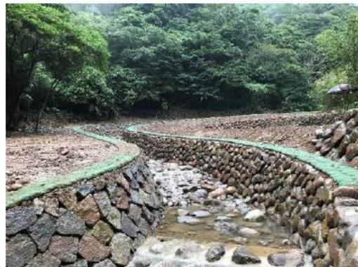
圖四 石門區阿里荖溪上游護岸崩塌整治工程
