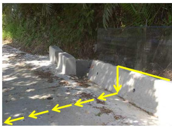
圖四 誘導網引導生物至集水井，通過涵管穿越道路
