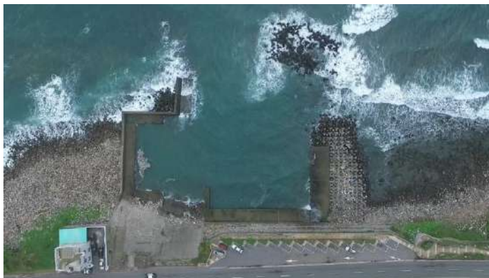
圖一 永興漁港拆除前空拍圖
