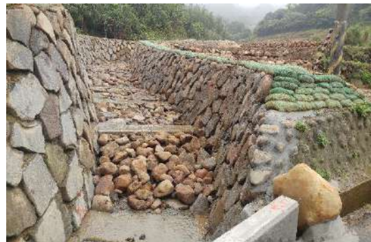
圖十 石門區山溪里九芎林溪支流米塔颱風災害復建工程-完工情形
