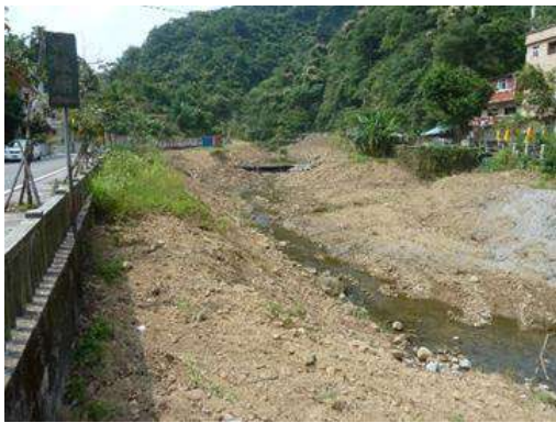
圖一 施工前雜草叢生
