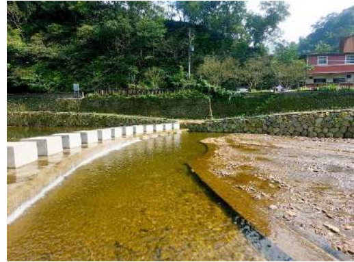
圖二 石碇區永定里姑娘廟前野溪整治工程
