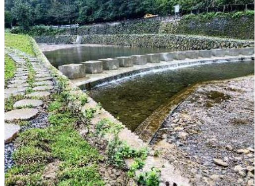
圖四 施工後砌石護岸 2
