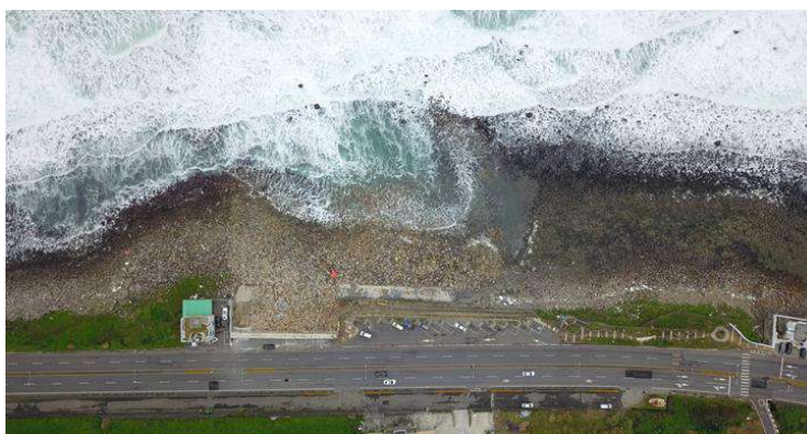
圖二 永興漁港拆除後空拍圖
