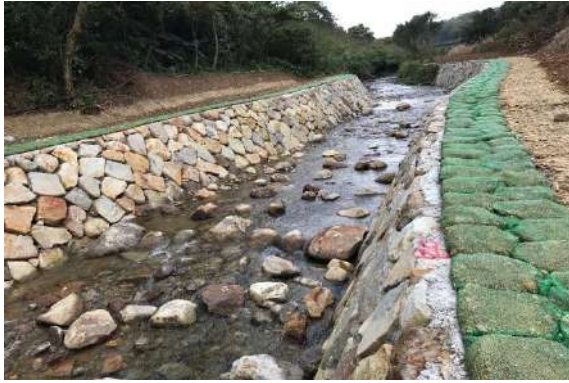
圖一 萬里區雙興里麗水 2-1 號旁野溪整治二期工程
