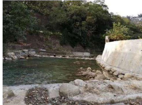
圖六 三峽區安坑里安坑 107 之 2 號旁及鹿母潭溪上游利奇馬颱風災害復建工程-完工情形
