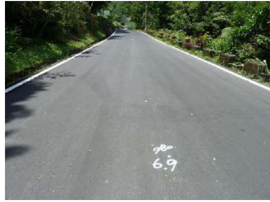
圖三 石碇區豐田里、彭山里及隆盛里農路改善工程-改善後
