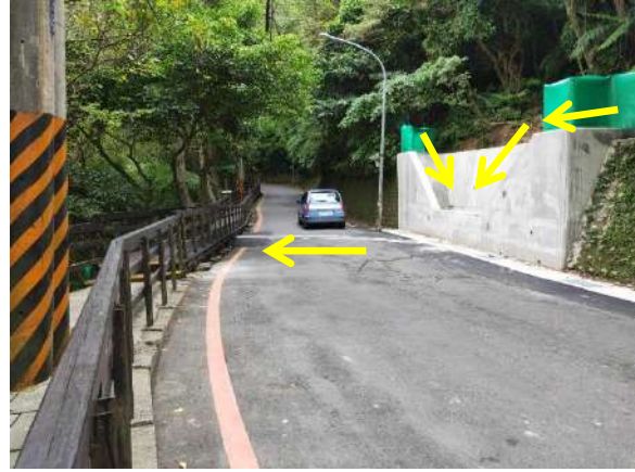
圖四 動物圍籬引導路線與截水溝施作， 使野生動物能安心穿越馬路-改善後
