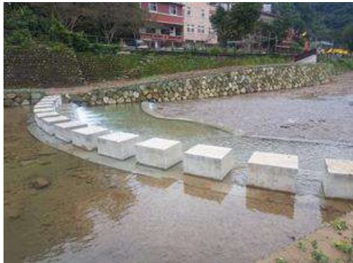
圖五 固床工營造深潭、淺灘交錯 1
