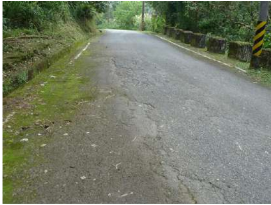
圖二 石碇區豐田里、彭山里及隆盛里農路改善工程-改善前
