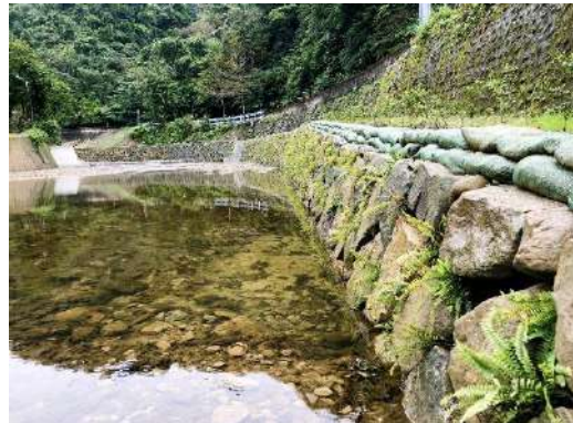
圖八 砌石工法之生態工程
