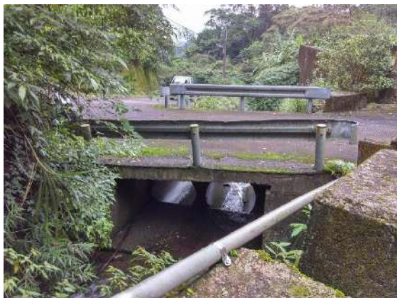
圖四 新店區農北店 002、003 及銀河路道路改善工程-改善前
