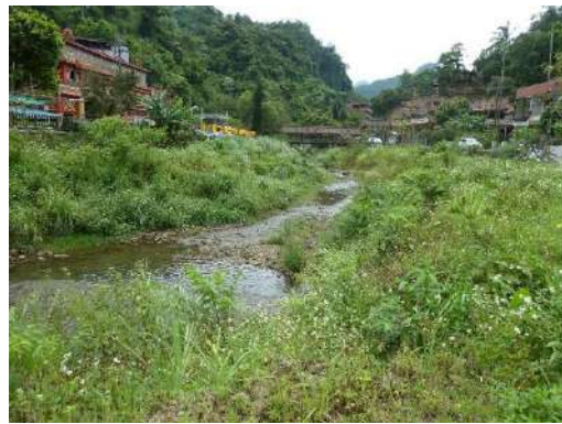
圖二 施工前雜草叢生
