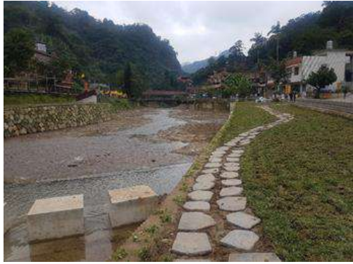
圖三 施工後砌石護岸 1
