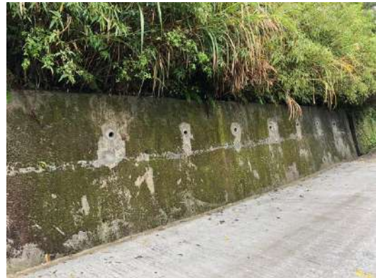
圖八 烏來區卡拉莫基 (路燈編號 164351) 米塔颱風災害復建工程-完工情形
