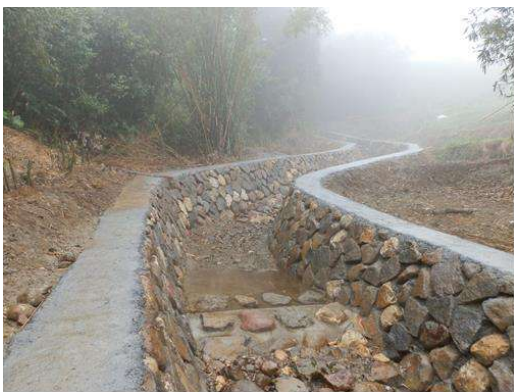
圖三 金山區三界里半嶺 19 號至 49 號旁溪流整治工程
