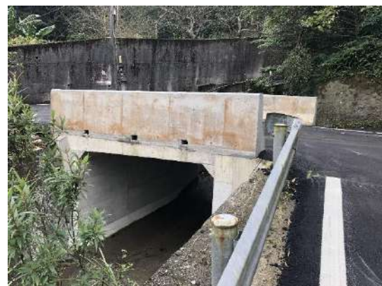
圖五 新店區農北店 002、003 及銀河路道路改善工程-改善後
