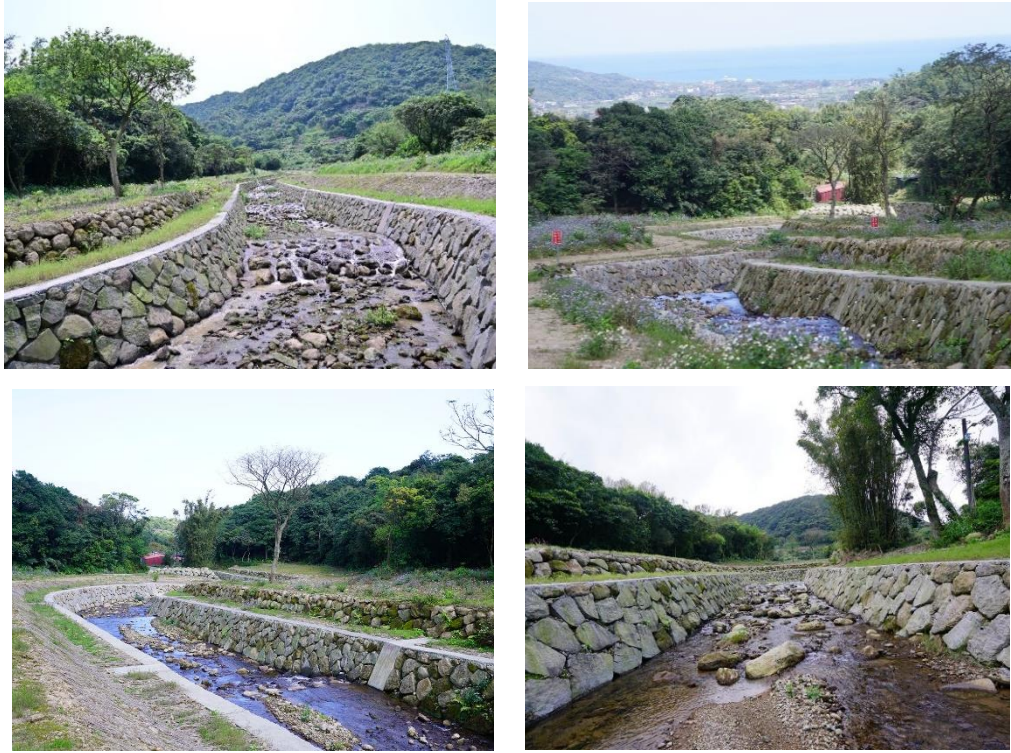
圖一、金山區南勢湖 72 號附近護岸山陀兒颱風復建工程完工後照片
